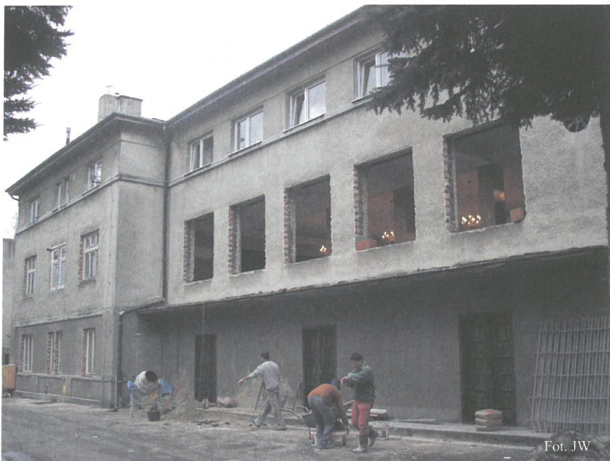
Odkryte kolumny w sali widowiskowej
