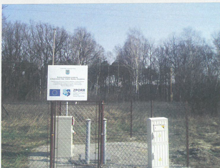
Budowa kanalizacji w Kłaju - największy realizowany dotąd projekt współfinansowany ze ZPORR
