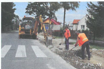
Wykonanie nowej 200 metrowej nawierzchni traktu w Targowisku.
