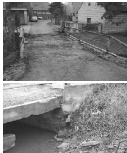
Stan obiektu przed rozpoczęciem prac modernizacyjnych
