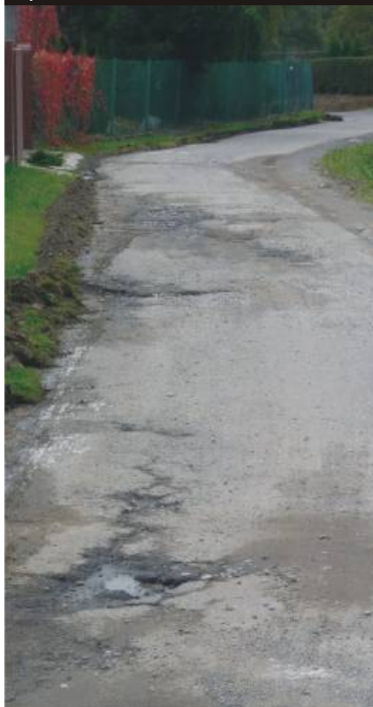
Przed rozpoczęciem prac
