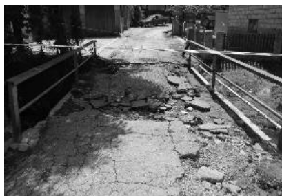
Stan obiektu przed rozpoczęciem prac modernizacyjnych
