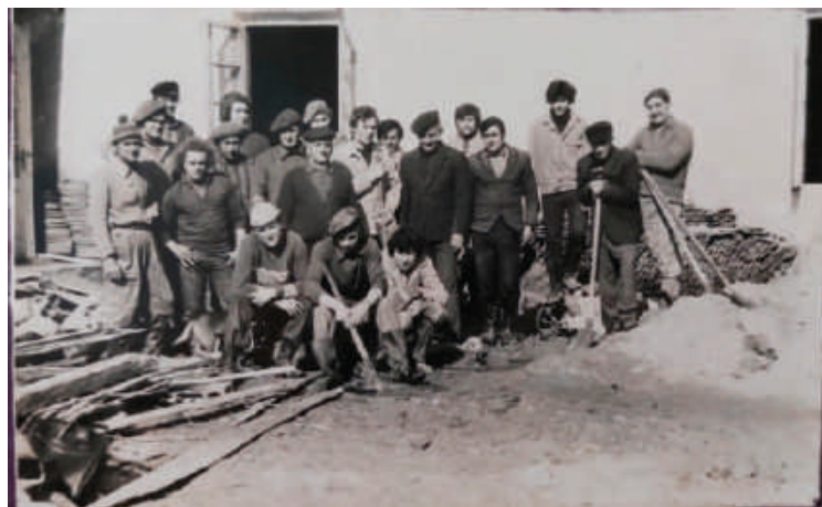
Fot. 5. Mieszkańcy na placu budowy przy WDK. (Źródło: Księga pamiątkowa z roku 1979)
