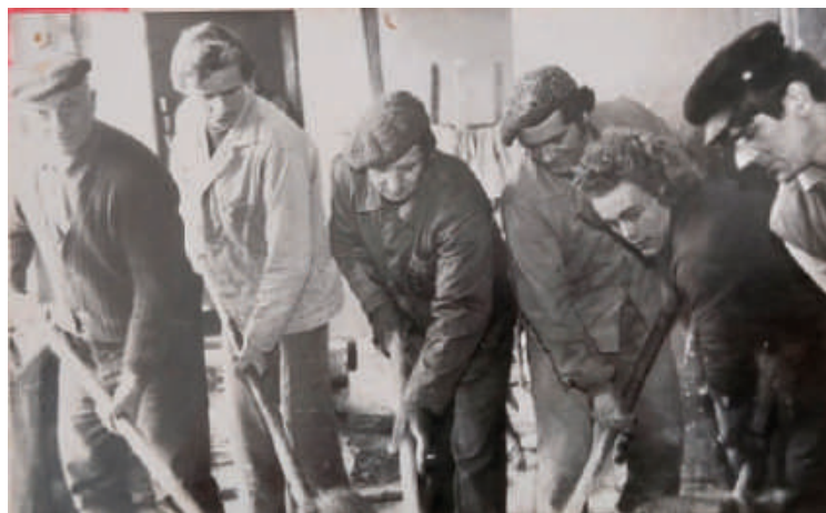
Fot. 4. Prace wewnątrz budynku. (Źródło: Księga pamiątkowa z roku 1979)
