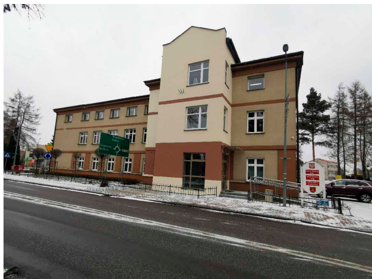
Winda w budynku Urzędu Gminy w Kłaju
